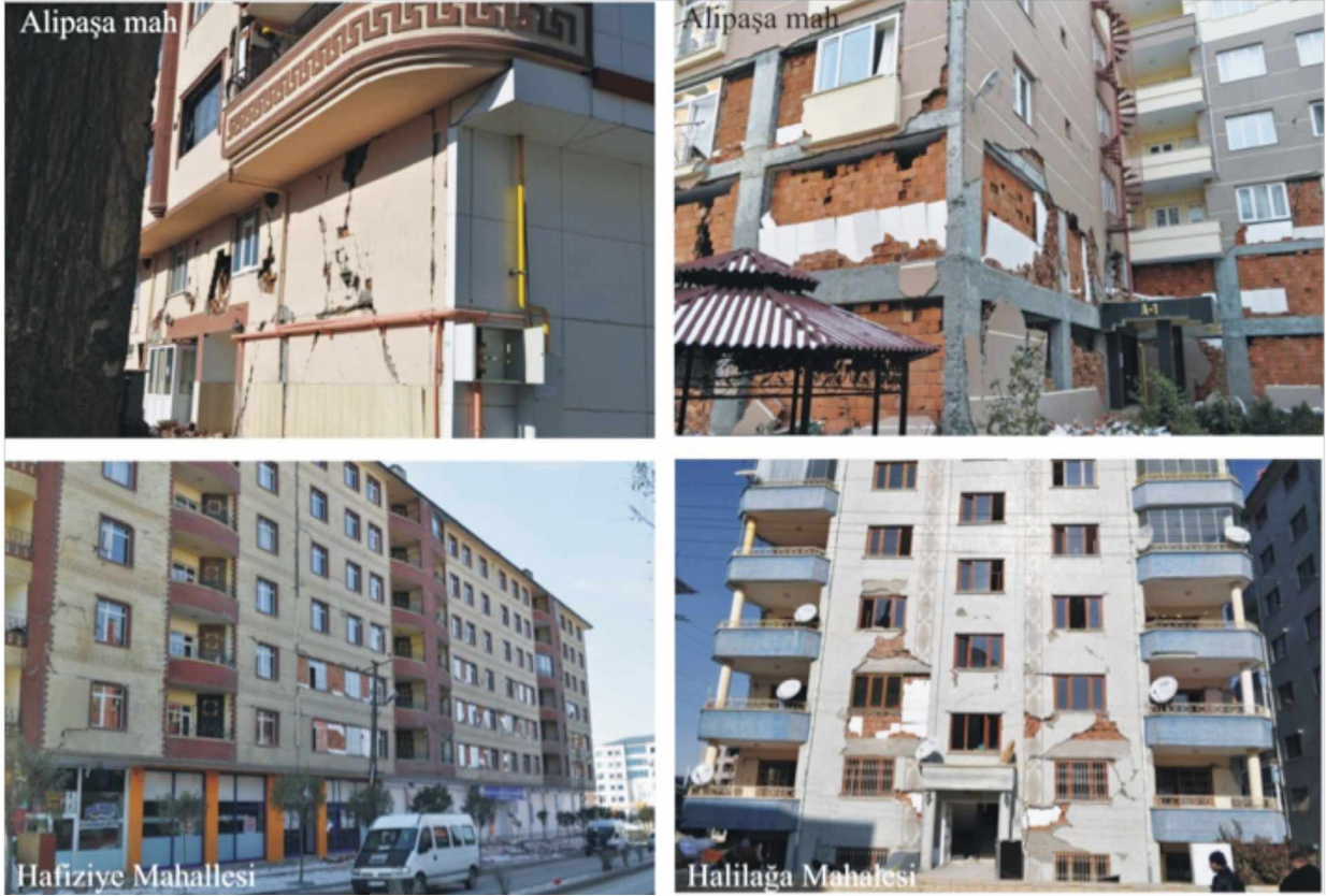
Şekil 10. Hasar derecesinin yüksek olduğu mahallelerden görünüm.
